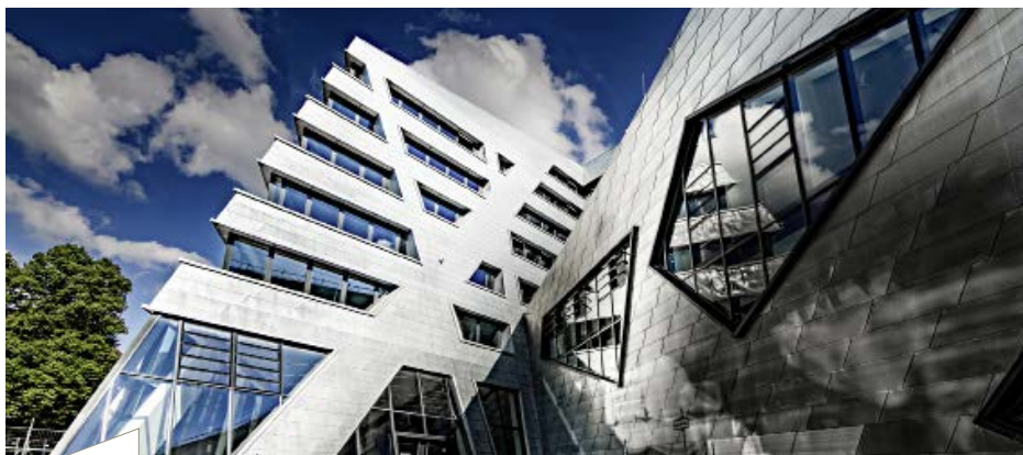
Der Sonnenschutz für die speziellen Fensterformen des Leuphana Gebäudes wird mit dimmbaren Gläsern erzielt.
